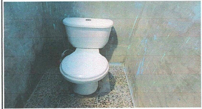
Foto 2: Sustitución de inodoros
