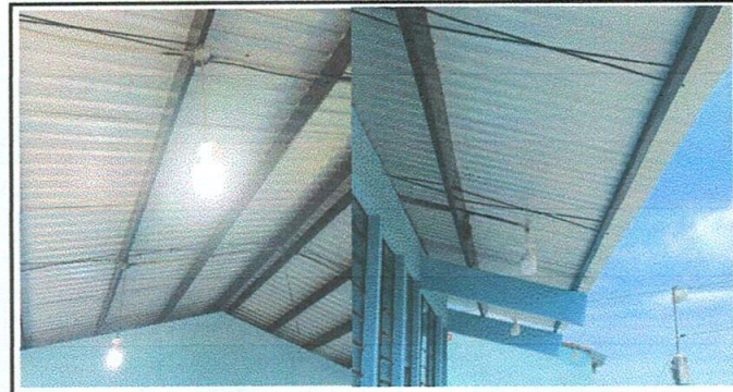
Foto 6: Sustitución de lamparas LED Ahorradores.
