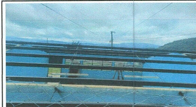
Foto 3: Sustitución de estructura de techo
