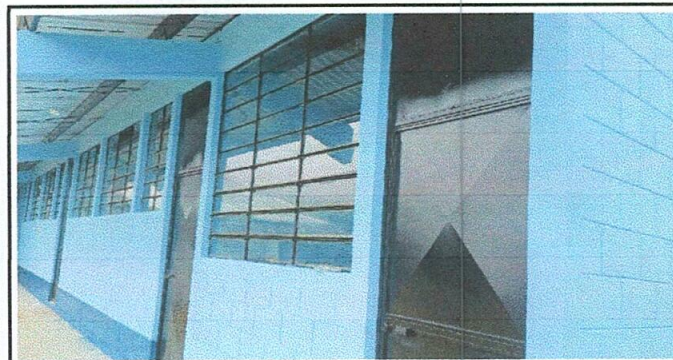
Foto 5: Pintura de pared de muros Interior y exterior.
