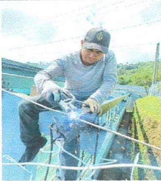
Foto 3: Sustitución de estructura de techo
