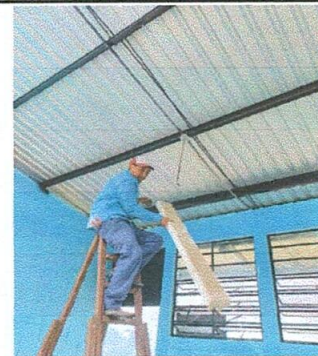
Foto 6: Cambio o sustitucion de lamparas LED
