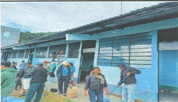
Foto 5: pintando muros interiores y exteriores
