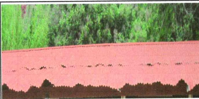
Foto 5: Sustitución de lámina por lámina troquelada aluzinc
