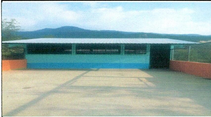
Foto 1: así quedo el cambio de lamina por lamina troquelada juntamente con costaneras
