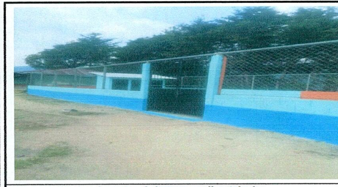
Foto 5: sustitucion de porton de ingreso, malla y tubo hg
