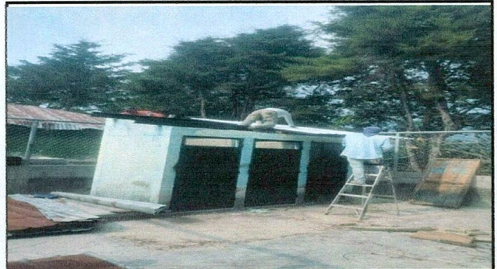
Foto 4: sustitucion de puertas de servicios de baños e inodoros juntamente con su cambio de costaneras y techo
