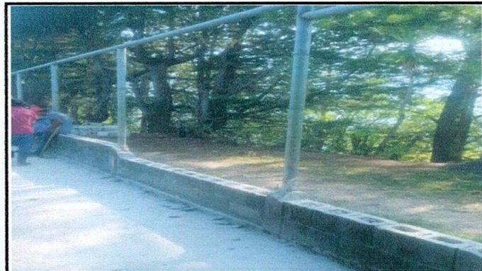
Foto 3: reparacion de muro perimetral de block
