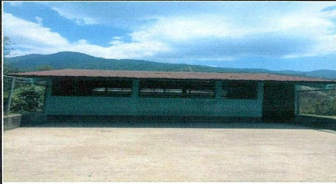
Foto 1: sustitucion de lamina, por lamina troquelada alucinc calibre 26
