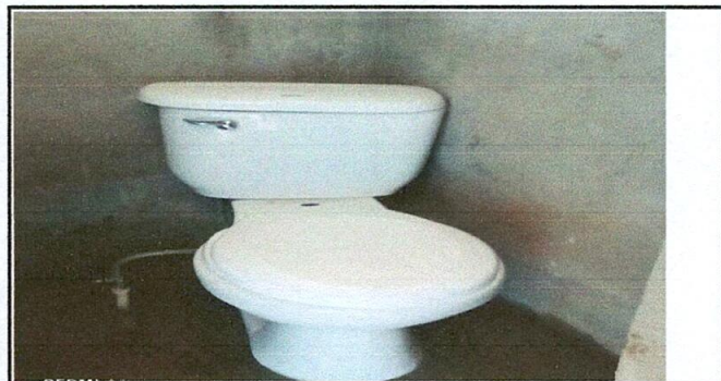
Foto 6: Inodoros nuevos instalados
