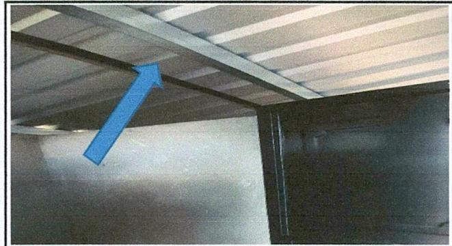
Foto 2: Estructura de metal instalado en baños
