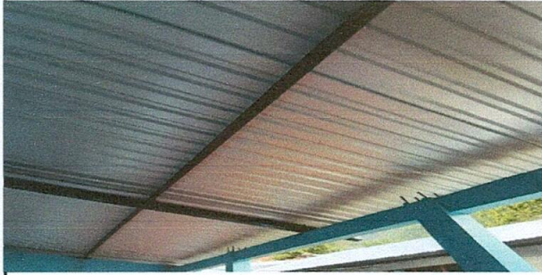
Foto 7: lijado y pintado de estructura de soporte de metal terminado
