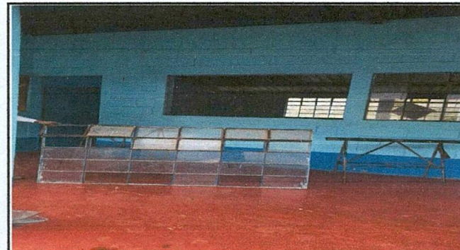
Foto 4: Quitando ventanas deterioradas
