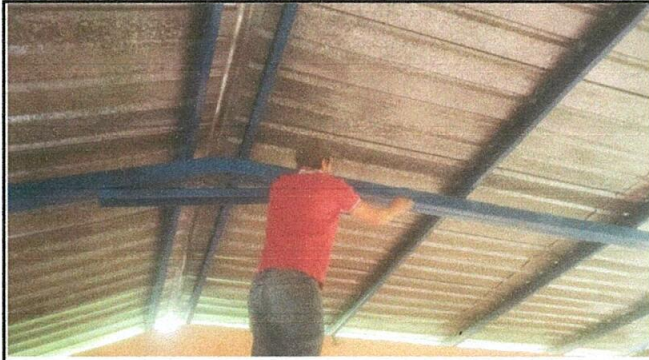
Foto7: lijando y pintando la estructura de soporte de metal
