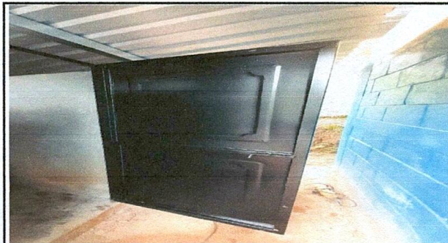
Foto 3: sustituyendo puerta en baños
