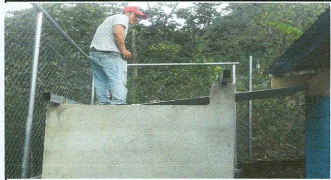
Foto 2: Cambiando estructura de madera por metal, en baños
