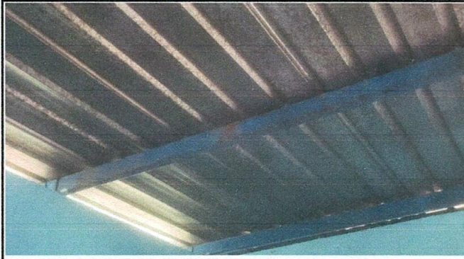
FOTO 7: Estructura de soporte de metal deteriorada
