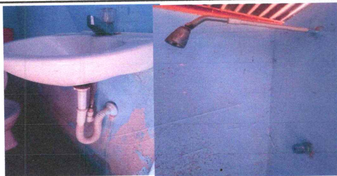
Foto 5: SUSTITUCIÓN DE LAVAMANO Y DE DUCHA (REGADERA)
