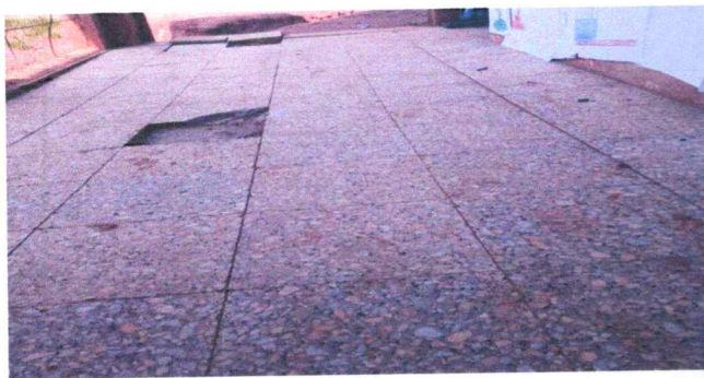
Foto 3: SUSTITUCION DE PISO EN GRANITO DE 177 METROS CUADRADOS
