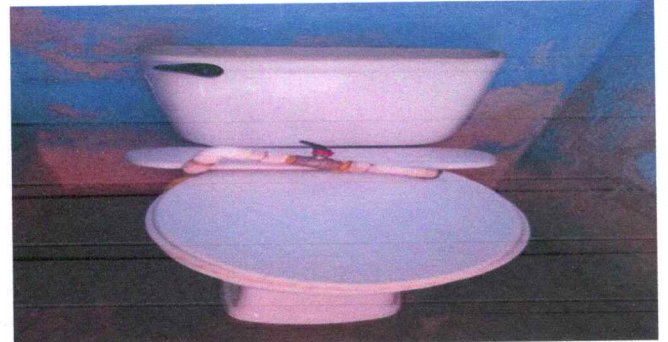
Foto 4: SUSTITUCION DE INODORO
