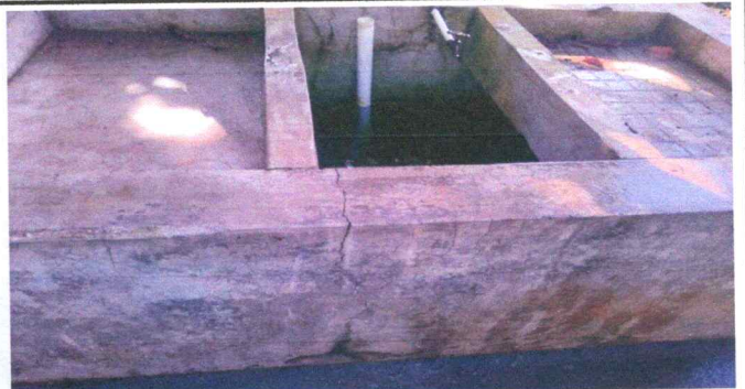
Foto 6: SUSTITUCION DE PILA DE CEMENTO DE 2 LAVADEROS DE 2MTSX60CMS
