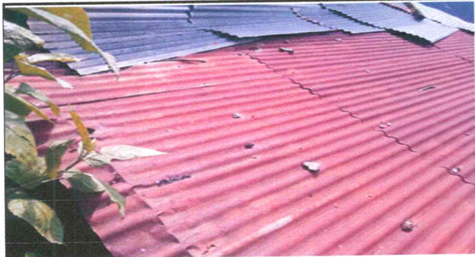
Foto1: SUSTITUCION DE LAMINA TROQUELADA CALIBRE 26
