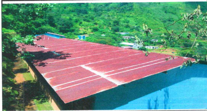
Foto1: Sustitución de lámina, por lámina troquelada aluzinc calibre 26 en 2 aulas
