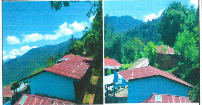
Foto 2: Sustitución de lámina, por lámina troquelada aluzinc calibre 26 en 2 aulas
