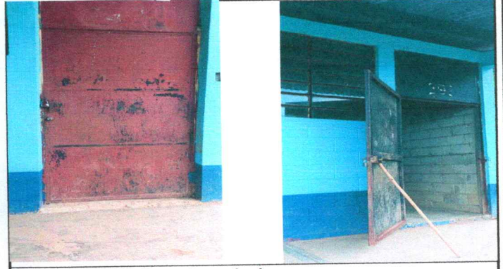
Foto 2: Sustrucción de puertas en 4 aulas
