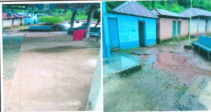
Foto 3: Reparación de planchas de concreto de patio
