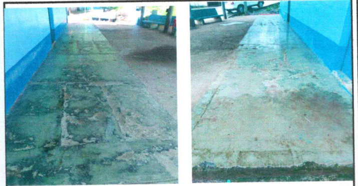
Foto 2: Reparación de piso de cemento líquido en dos Aulas y Corredor
