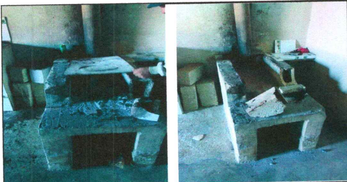
Foto 5: Sustitución de estufa rural (completa) incluye chimenea y plancha de metal
