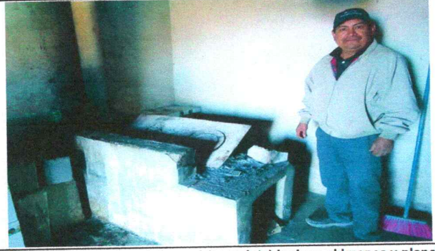
Foto 6: Sustitución de estufa rural (completa) incluye chimenea y plancha de metal
