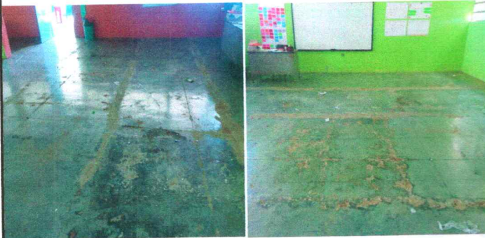
Foto 1: Reparación de piso de cemento líquido en dos Aulas y Corredor
