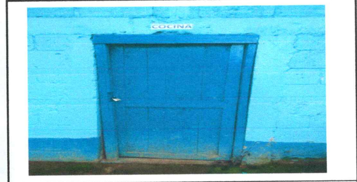
Foto 6: Sustitución de Puertas de Madera a Metal en Cocina.
