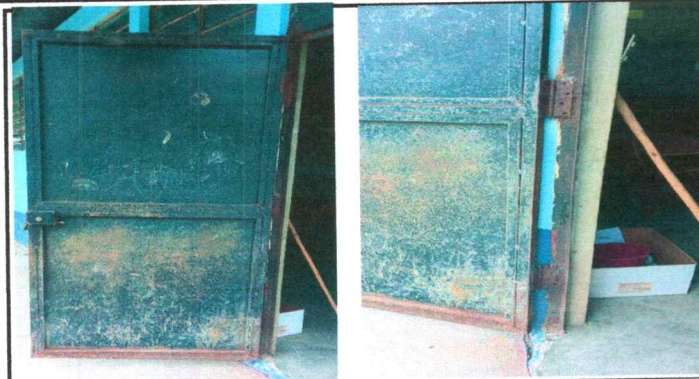
Foto1: Sustrucción de puertas en 4 aulas
