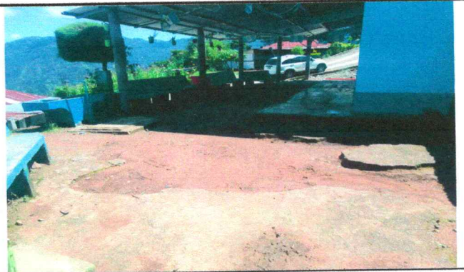
Foto 4: Reparación de planchas de concreto de patio
