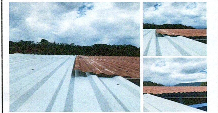
Sustitución de lamina por lamina troqueleada aluzinc calibre 26
