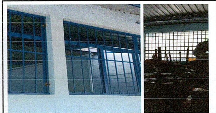
Sustitución de estructura de metal de ventana
