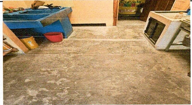
Sustitución de piso de cemento líquido en cocina y corredor
