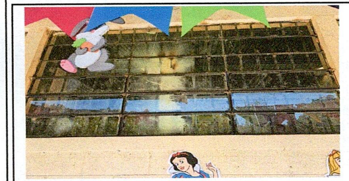
Sustitución de estructura de metal de ventana
