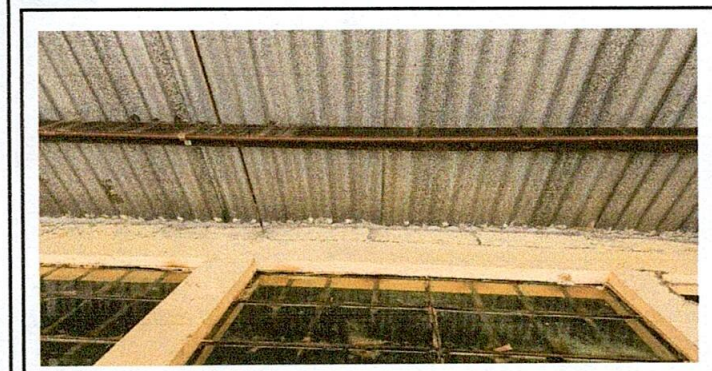
Mantenimiento a estructura de soporte de metal
