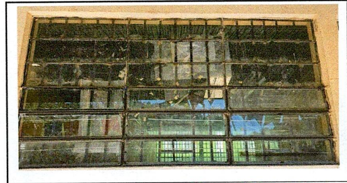
Sustitución de vidrios para ventanas
