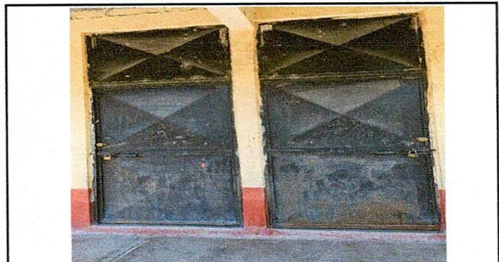
Mantenimiento a estructura de puerta de metal (lijado, aplicación de pintura)
