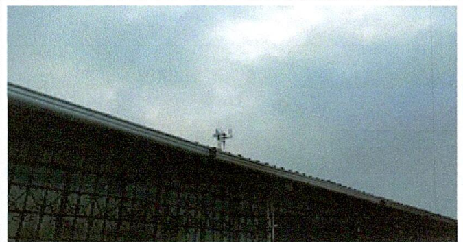
SE REALIZARÁ SUSTITUCIÓN DE CANALES Y BAJADA DE AGUA PLUVIAL
