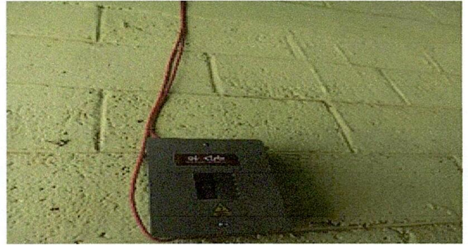
SE REALIZARÁ REPARACIÓN DE SISTEMA ELÉCTRICO
