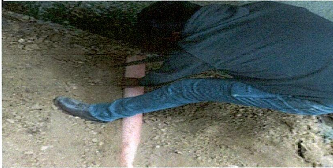
SE REALIZARÁ SUSTITUCIÓN DE TUBO PVC PARA AGUAS NEGRAS Y LLEVES DE HORROS
