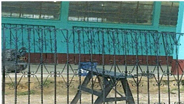
SE REALIZARÁ SUSTITUCIÓN DE VIDRIOS Y MANTENIMIENTO A BALCONES DE METALES
