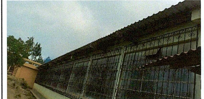
SE REALIZARÁ SUSTITUCIÓN DE CANALES Y BAJADA DE AGUA PLUVIAL
