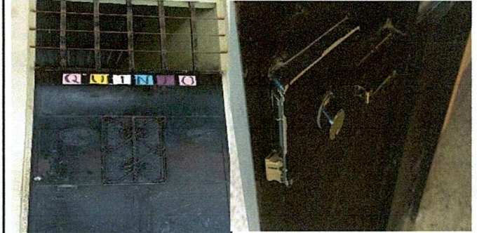
SE REALIZARÁ MANTENIMIENTO DE DE PUERTA Y SUSTITUCIÓN DE CHAPAS
