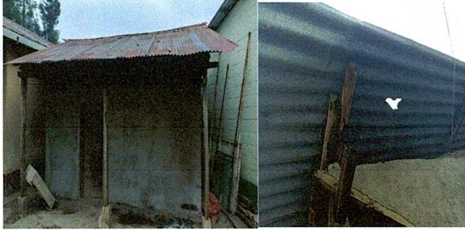
SE REALIZARÁ LA SUSTITUCIÓN DE TECHO Y ESTRUCTURA DE SOPORTE DE MADERA POR METAL
