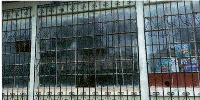
SE REALIZARÁ SUSTITUCIÓN DE VIDRIOS Y MANTENIMIENTO A BALCONES DE METALES
