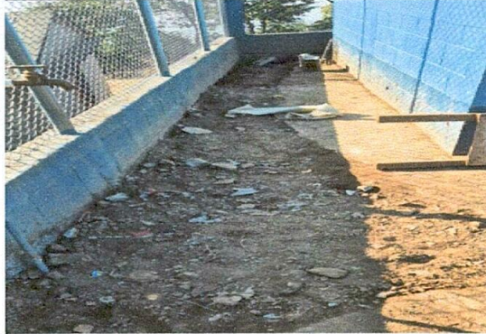
SUSTITUCIÓN DE PISO
