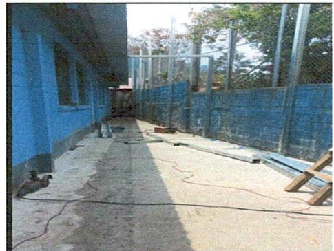
SUSTITUCIÓN DE CANAL Y TECHO
