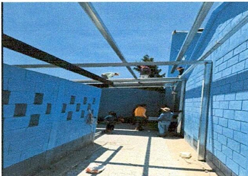
INSTALACIÓN DE TECHO
