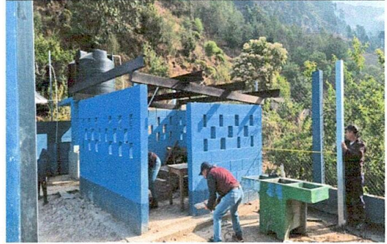
INSTALACIÓN DE ESTRUCTURA PORTANTE
