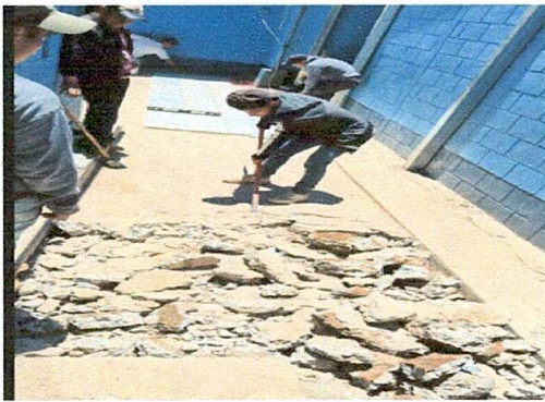
SUSTITUCIÓN DE PISO
