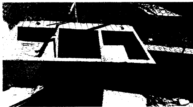
Se realizará sustitución de la pila ya que la actual lleva años y no se encuentra en buenas condiciones.
