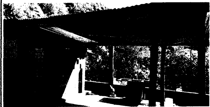
Aquí se realizará sustitución de techo y estructura de soporte
