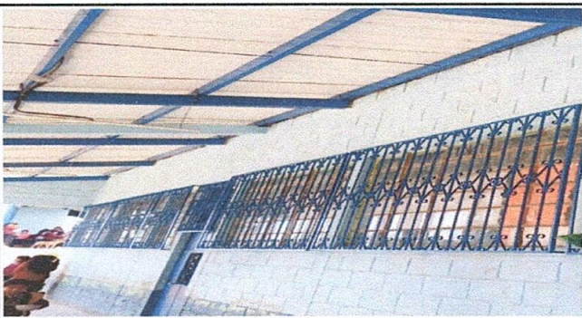
Foto 5. Reparacion de sustitucion de balcones.
