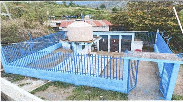
Foto 3. Reparacion de cerco de alambre a baranda
