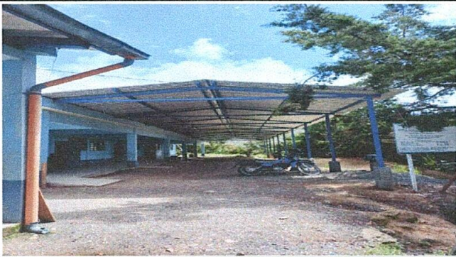
Foto 1. Sustitucion de estructura de Soporte
