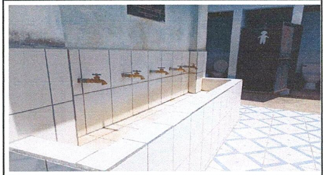
Foto 4. Reparacion de multichorros
