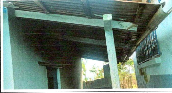
Foto 6: Sustitución de canales de PVC y bajada de agua pluvial
