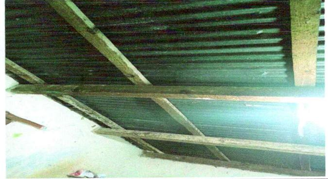
Foto 2: Sustitucion de lamina y estructura de soporte
