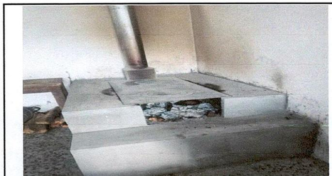
Foto 11: instalación de estufa rural (completa) incluye chimenea y plancha de metal.
