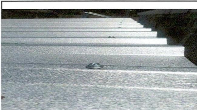
Foto 2: instalación de tornillos.
