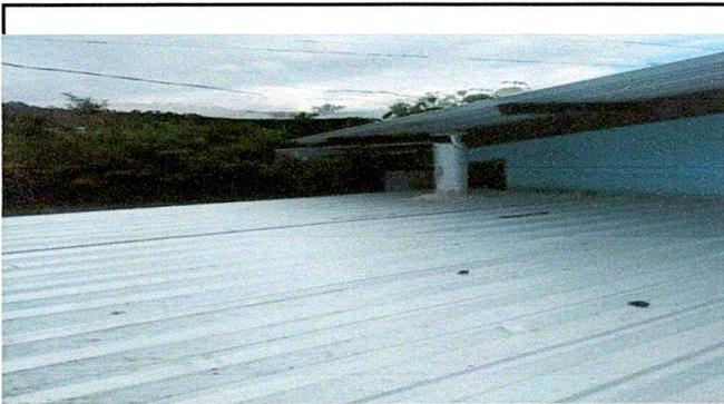
Foto 1: intalación de lámina troquelada calibre 26.
