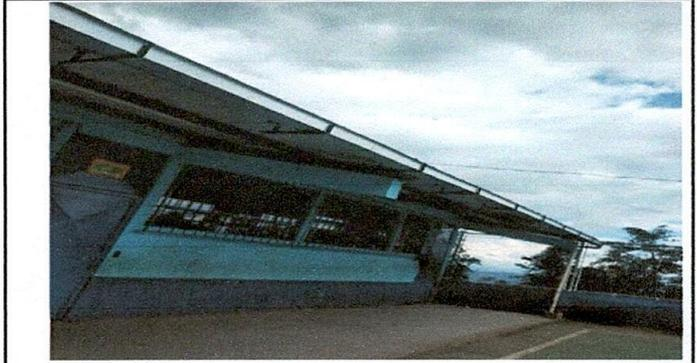
Foto 8: instalación de canal de metal.
