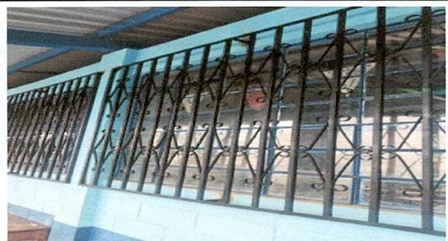
Foto 6: instalación de balcones de metal con angular de 1 pulgada y tubo cuadrado de 3/4.
