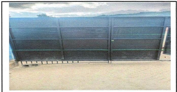
Foto 12: fabricación e instalación de portón de metal de ingreso (mano de obra).
