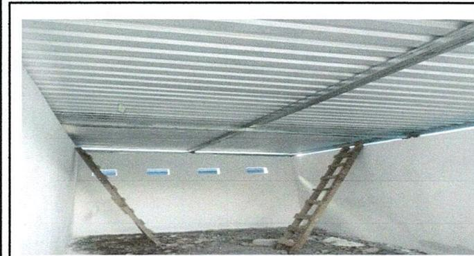
SUSTITUCIÓN DE LÁMINA TROPQUEALADA CALIBRE 26
