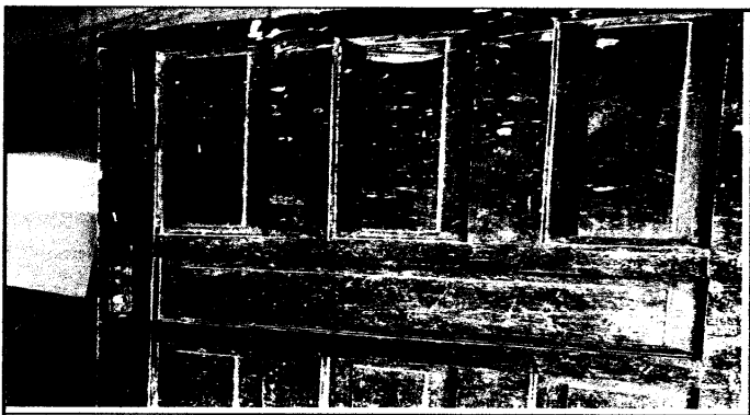
Foto 3: Sustitucion de puerta
