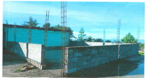
Foto 6: CUBIERTA DE LÁMINA
