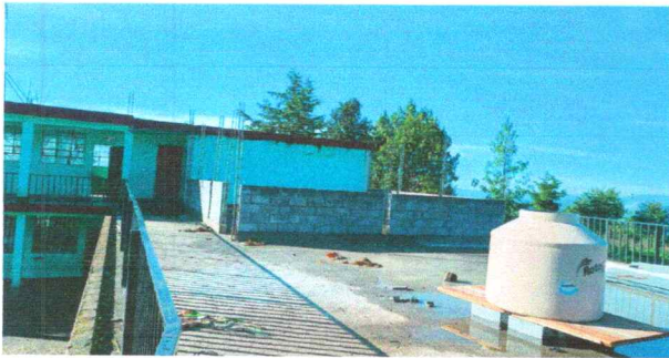
Foto 5: CANALES Y BAJADAS DE AGUA PLUVIAL
