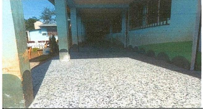
Foto 8: Sustitución de piso granito en corredor
