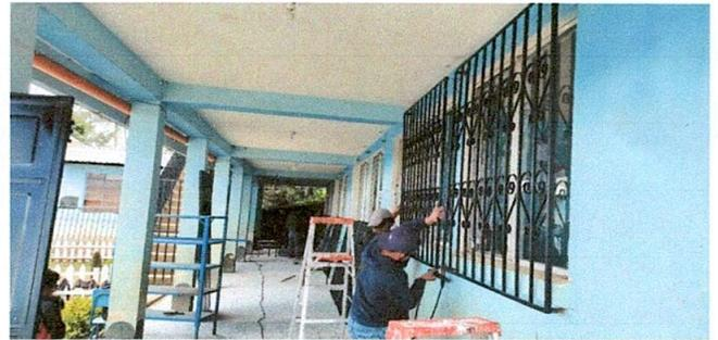
Foto 6: Mantenimiento a Balcones de Metal en aulas
