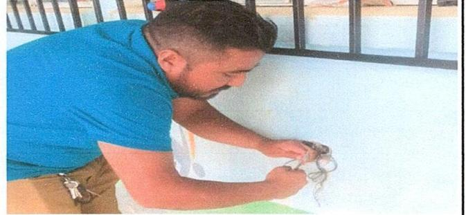
Foto 14: Sustitución de tomacorrientes dobles
