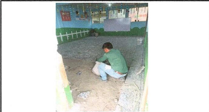
Foto 7: Sustitución de Piso de granito en aulas
