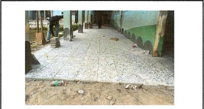
Foto 8: Sustitución de piso granito en corredor
