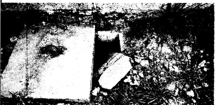
Foto 11: Sustitución de tubería aguas pluviales y caja de registro
