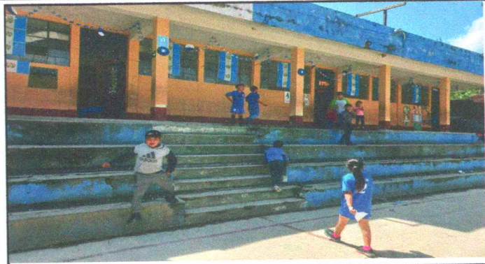
FOTO 2: REPARACION EN GRADERILLO
