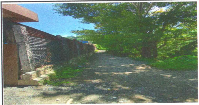
FOTO 6: REPARACIÓN DE MURO DE CIRCULACIÓN
