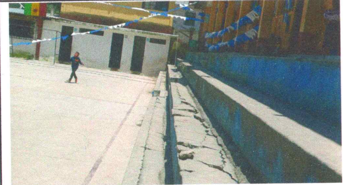
FOTO 4: REPARACIÓN DE GRADERILLO
