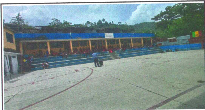
FOTO 3: PINTURA EN GRADERILLO
