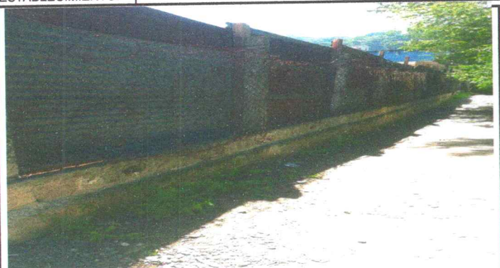
FOTO 1: REPARACION DE MURO
