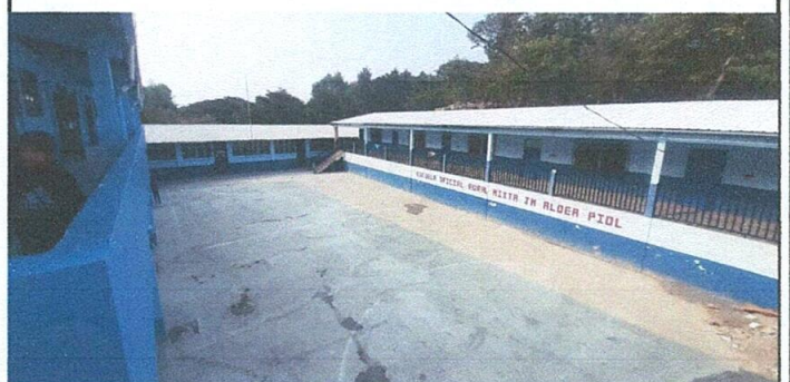
Foto 4: Pavimentación Finalizado de la cancha polideportiva.
