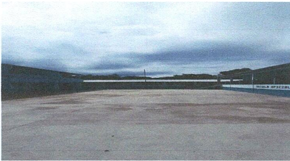
Foto 5: pavimento en proceso de secado.
