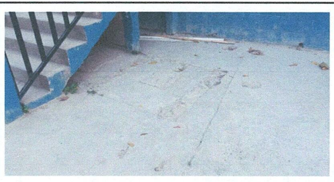
Foto 6. Deterioro por la construccion de la fosa séptica
