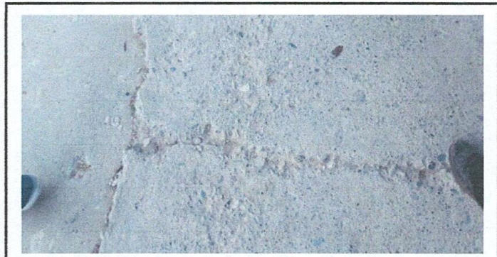
Foto 5. Grietas provocadas por la inestabilidad del subsuelo.
