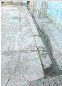
Foto 5: Cuneta de concreto
