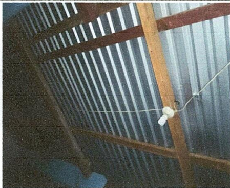
Foto 9: Reparación de sistema eléctrico
