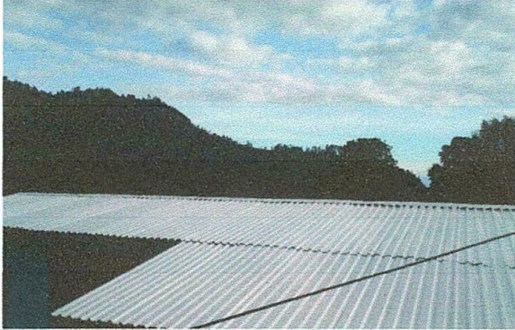
Foto 1: Cubierta de lámina
