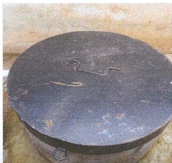
Foto 11: Sustitución de bomba sumergible
