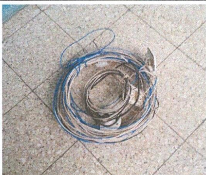
Foto 9: Reparación de sistema eléctrico
