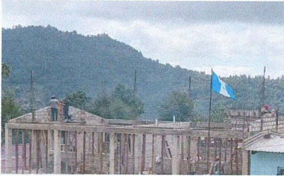
Foto 1: Cubierta de lámina
