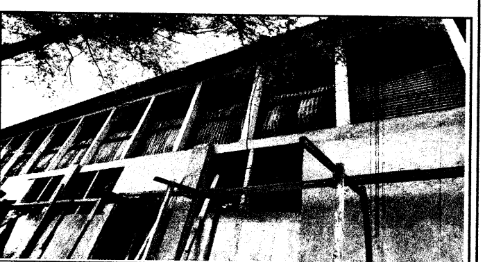
FOTO 6: SUSTITUCIÓN Y FABRICACIÓN DE BARANDAS DE METAL
