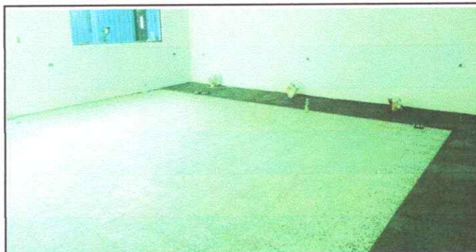
FOTO 5: SUSTITUCION DE PISO GRANITO
