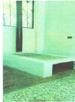
Foto 2: Remodelación de estufas
