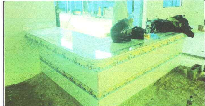
Foto 6: Sustitución de azulejos
