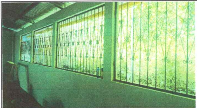
Foto 3: Sustitución de ventanas
