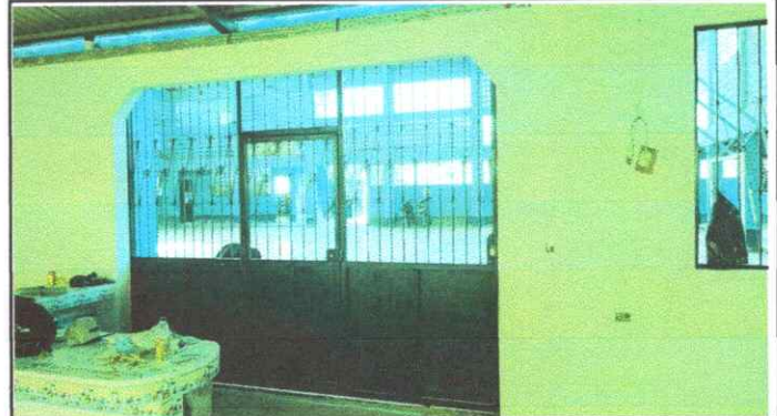
Foto 4: Sustitución de portón
