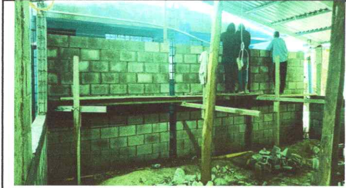
FOTO 1: REMODELACION DE COCINA
