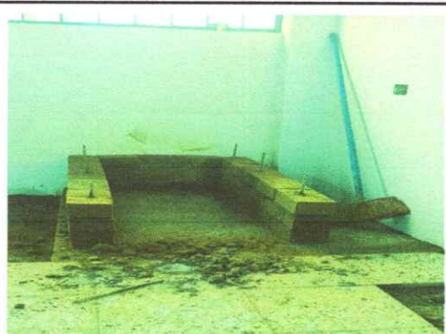
Foto 2: Remodelación de estufas
