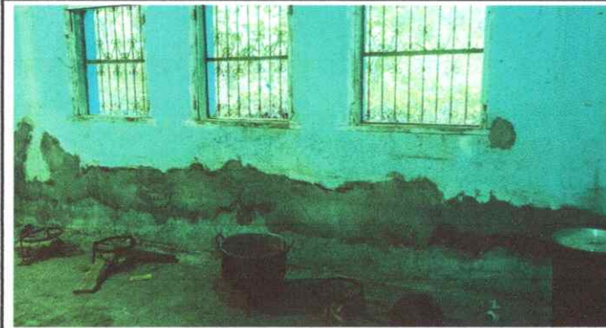
Foto 3: Sustitución de ventanas
