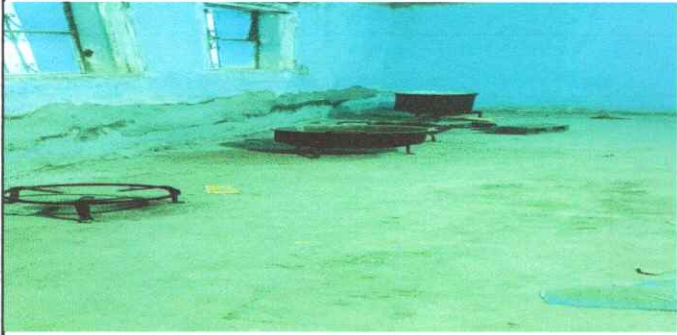
FOTO 1: REMODELACION DE COCINA
