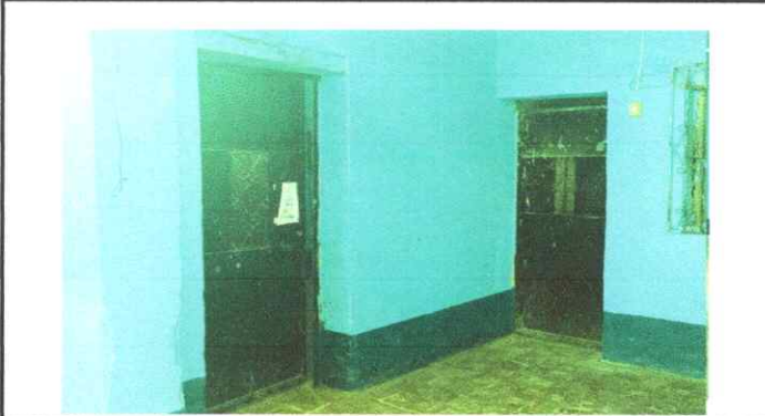
Foto 4: Sustitución de portón
