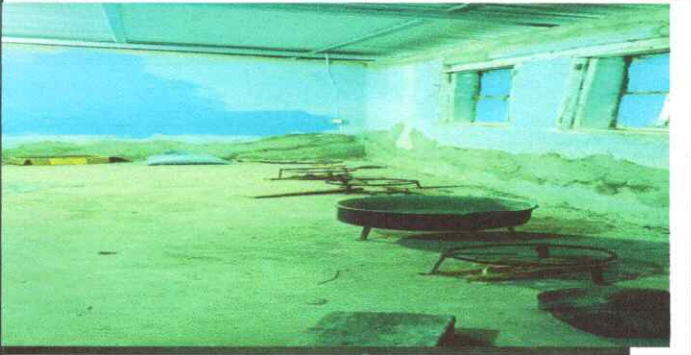
Foto 6: Sustitución de azulejos
