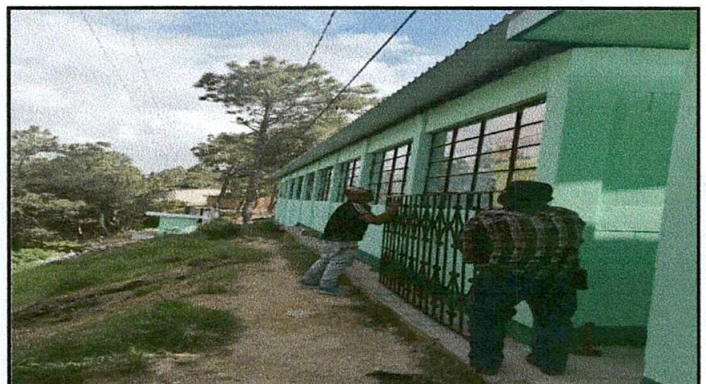
FOTO 4: sustitucion final de balcones
