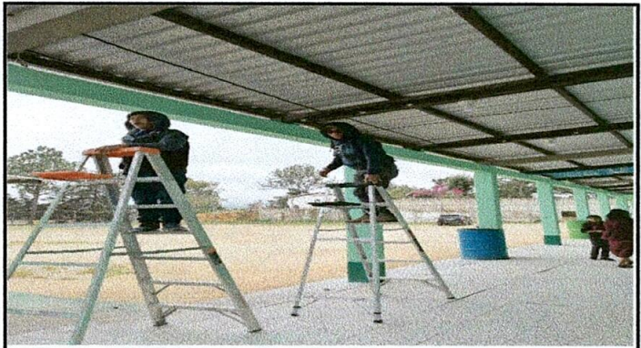
FOTO 3: sustitucion de cableado electrico
