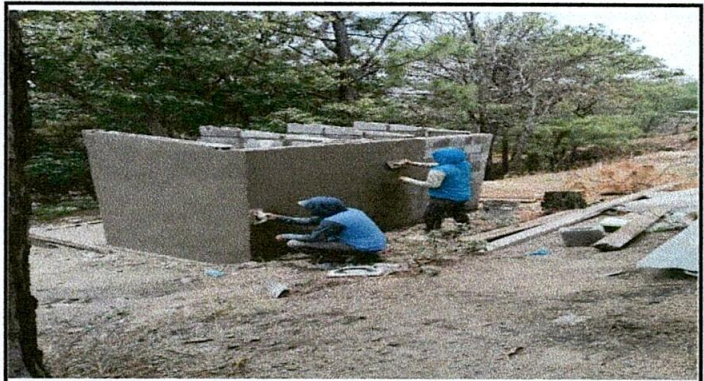
FOTO 1: sustitucion de paredes en servicios sanitarios
