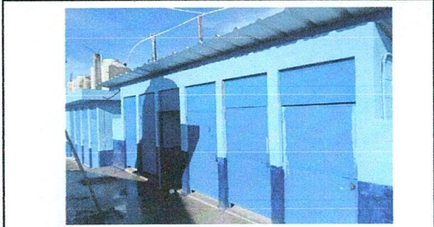
FOTO 2: SUSTITUCIÓN DE PUERTAS EN SERVICIOS SANITARIA
