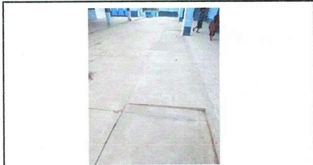
FOTO 4: REPERACIÓN PLANCHA DE CONCRETO DE PATIO
