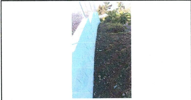
FOTO 1: SUSTITUCIÓN DE PINTURA DE LA CIRCULACIÓN DE LA ESCUELA
