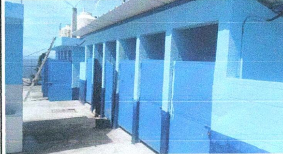
FOTO 2: SUSTITUCIÓN DE PUERTAS EN SERVICIOS SANITARIA
