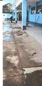
FOTO 4: REPERACIÓN PLANCHA DE CONCRETO DE PATIO
