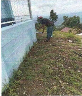
FOTO 1: SUSTITUCIÓN DE PINTURA DE LA CIRCULACIÓN DE LA ESCUELA
