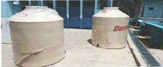
FOTO 3: SUSTITUCIÓN DE DEPOSITO DE AGUA DE MIL CIEN LITROS
