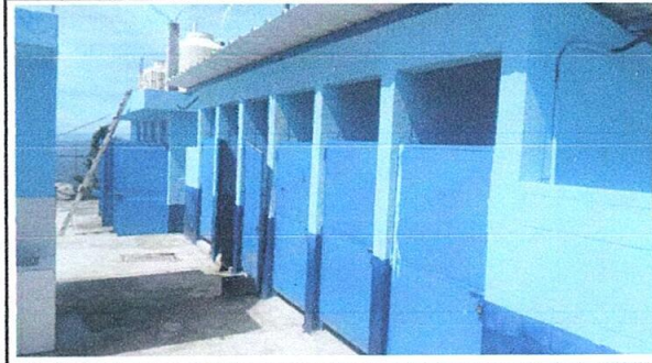
FOTO 2: SUSTITUCIÓN DE PUERTAS EN SERVICIOS SANITARIA
