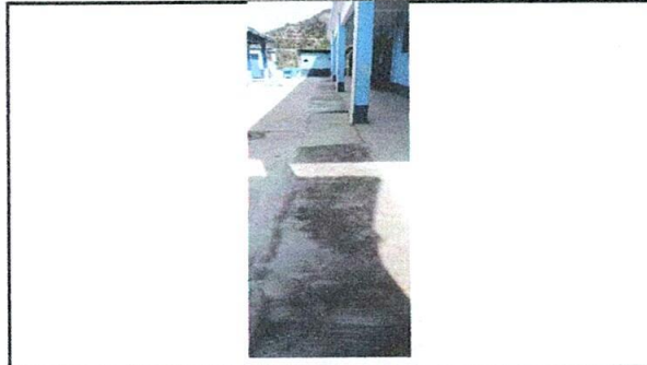
FOTO 4: REPERACIÓN PLANCHA DE CONCRETO DE PATIO
