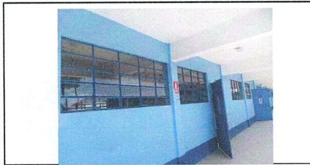
FOTO 5: SUSTITUCIÓN DE ESTRUCTURA DE METAL DE VENTANAS
