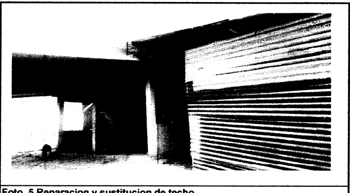
Foto. 5 Reparacion y sustitucion de techo
