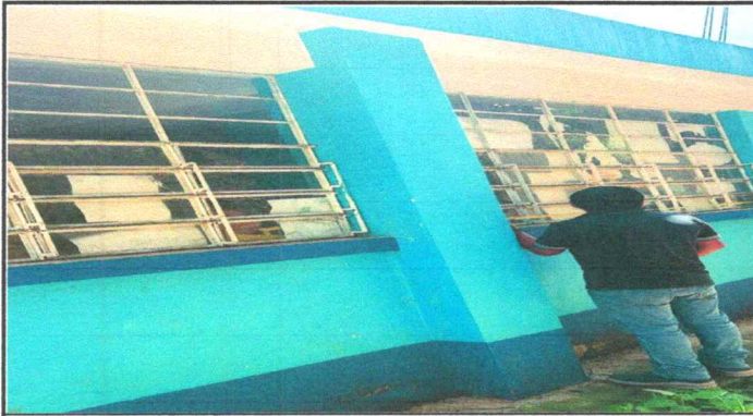
FOTO 1: SUSTITUCIÓN DE BALCONES DE METAL
