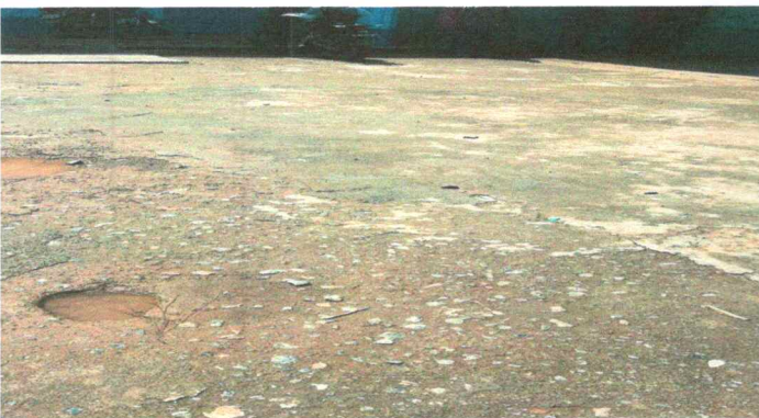
FOTO 5: REPARACIÓN DE PLANCHA DE CONCRETO
