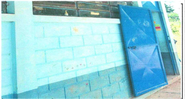
FOTO 6: REPARACIÓN DE PINTURA EN PUERTAS
