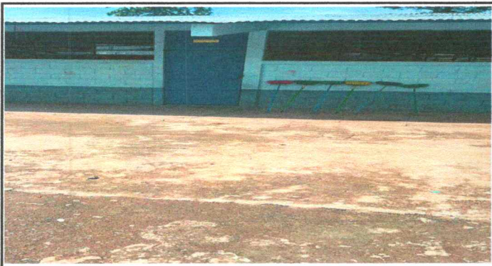
FOTO 3: PINTURA EN MUROS EXTERIORES E INTERIORES
