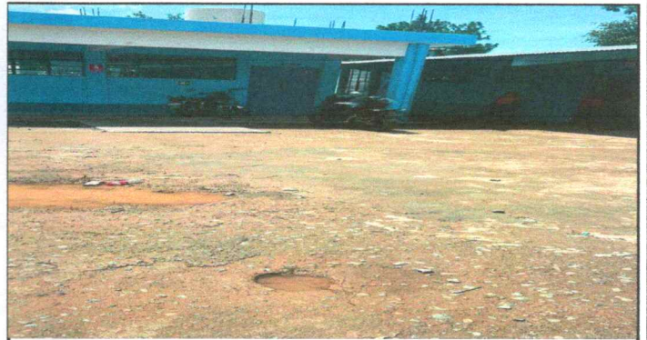
FOTO 4: PINTURA EN MUROS EXTERIORES E INTERIORES
