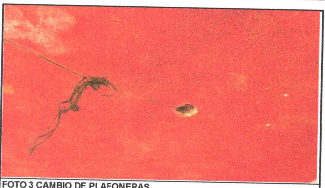
FOTO 3 CAMBIO DE PLAFONERAS
