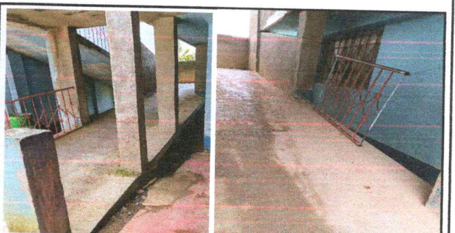
FOTO 6: SUSTITUCIÓN DE BARANDA DE METAL
