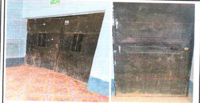
FOTO 1: MANTENIMIENTO A PUERTAS
