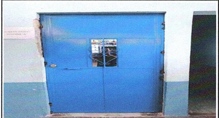
Foto 8. Sustitución de puerta de metal
