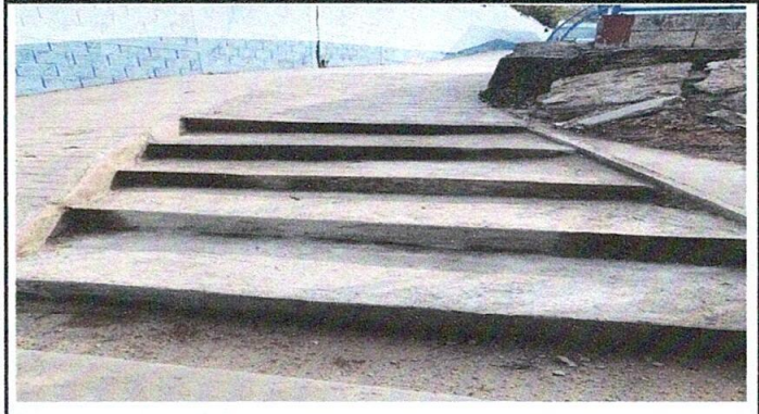
Foto 2. Rampa para módulos planta baja
