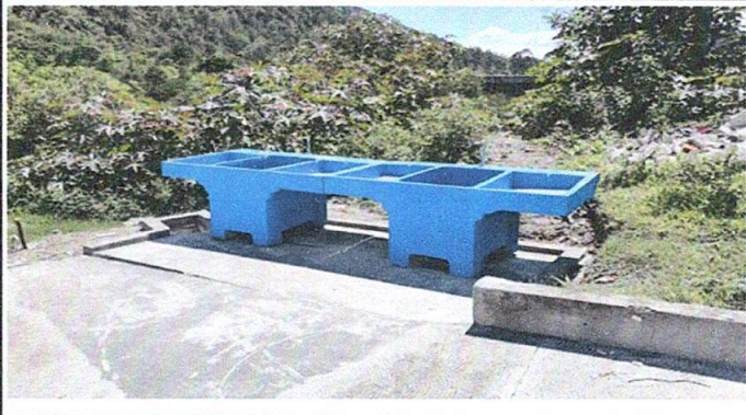
Foto 13. Pilas de cemento de dos lavaderos
