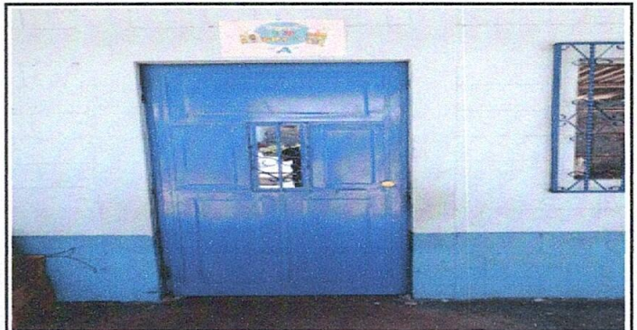
Foto 12. Sustitución de puertas de metal
