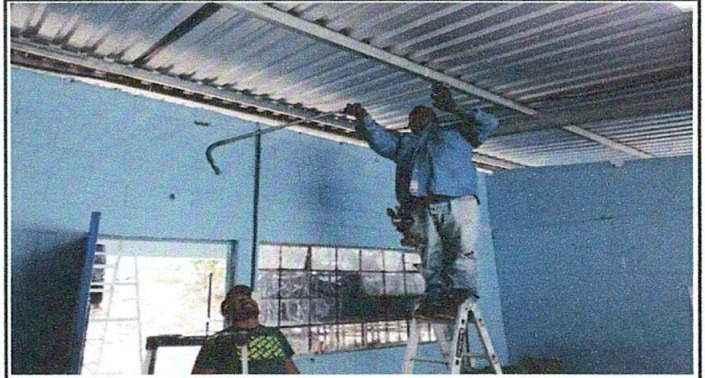
Foto 4. Instalación de cable eléctrico para plafoneras en el aula, planta baja.
