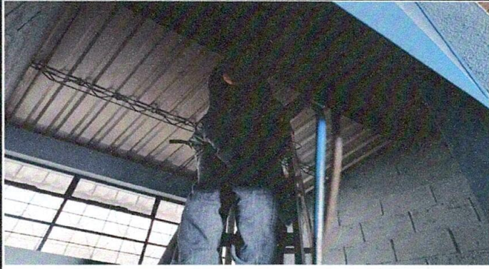
Foto 1. Instalación de cableado eléctrico, planta baja.
