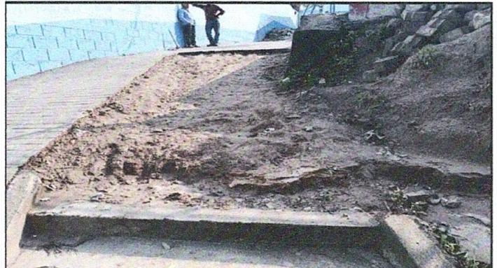
Foto 2. Rampa módulos planta baja
