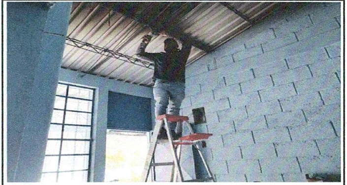
Foto 2. Instalación de plafoneras y focos, planta baja.
