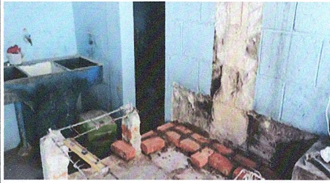
Foto 7. Chimenea de estufa rural
