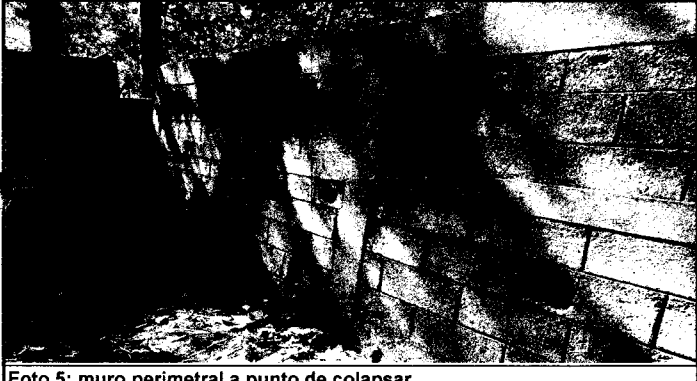
Foto 5: muro perimetral a punto de colapsar
