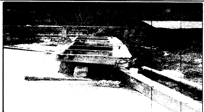
Foto 20: Pilas de cemento de dos lavaderos
