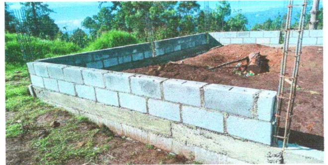
Foto 2: CUBIERTA DE LÁMINA
