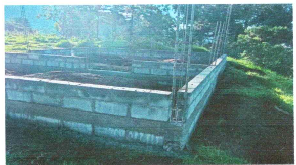
Foto 6: ESTRUCTURA DE TECHO
