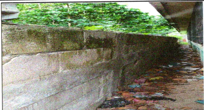
FOTO 1: PINTURA EN MUROS DE CIRCULACION
