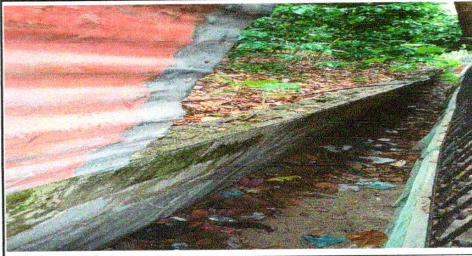
FOTO 2: REPARACIÓN EN MURO DE CONTENCIÓN
