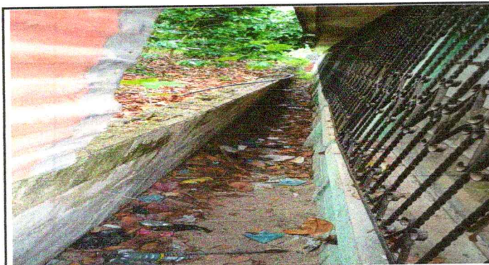
FOTO 3: APLICACIÓN DE REPELLO EN MURO DE CONTENCIÓN
