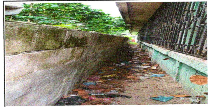
FOTO 6: REFORZAMIENTO DE SOLERAS
