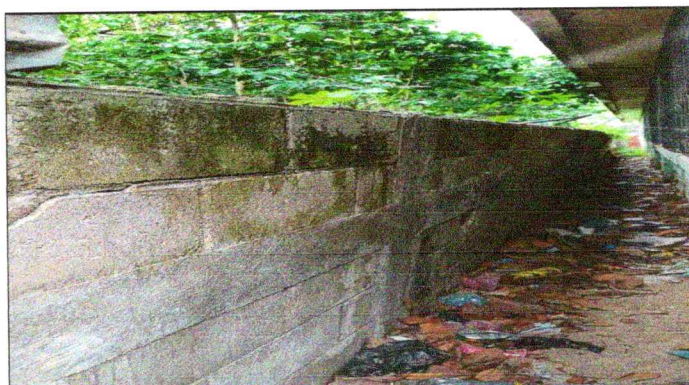
FOTO 4: SELLADO DE GRIETAS EN MURO
