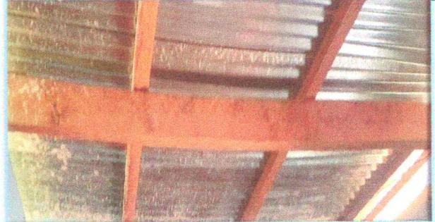
FOTO 4: SUSTITUCIÓN DE ESTRUCTURA DE SOPORTE DE TECHO
