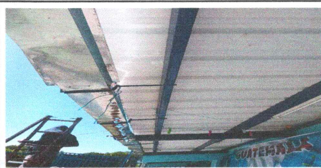
Foto 6: Sustrucción de canal de metal
