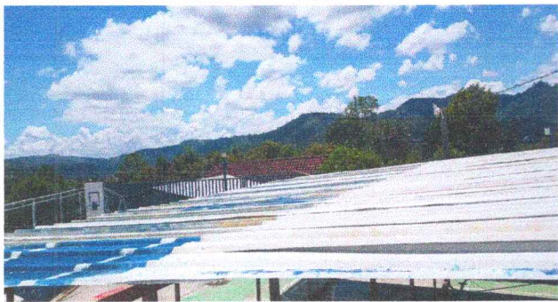
Foto 1: Sustrucción de lamina, por lámina troquelada calibre 26
