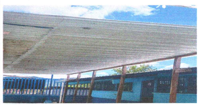
Foto 2: Sustrucción de lamina, por lámina troquelada calibre 26
